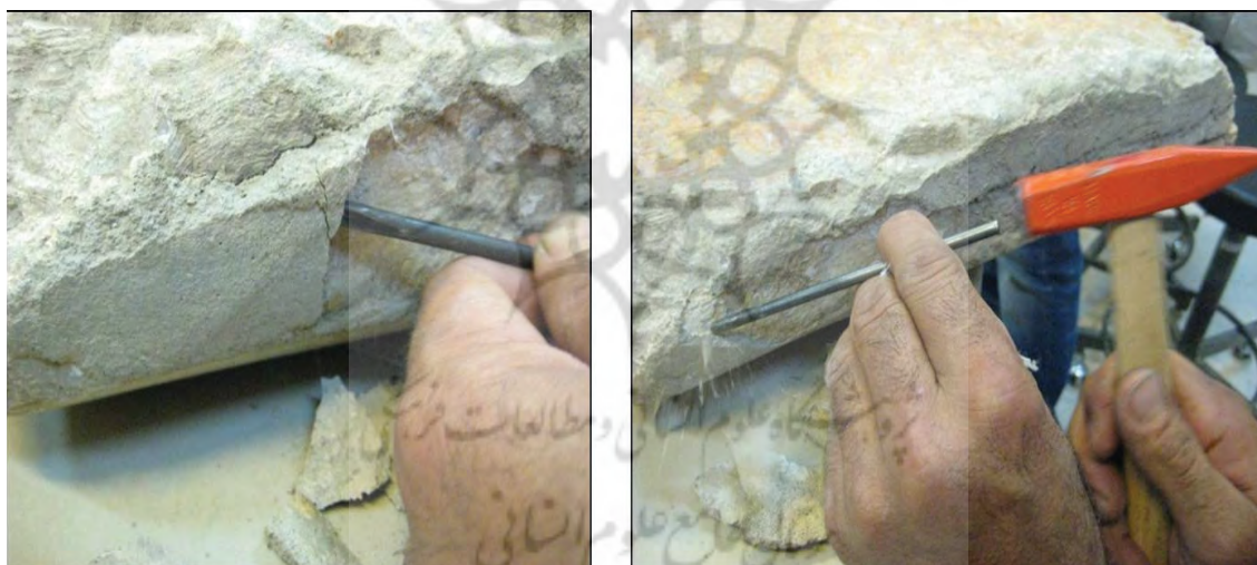
ت. ۹. پاکسازی مواد و ملات‌های چسبنده همچون سیمان به وسیله قلم و چکش(ماخذ: نگارندگان)
