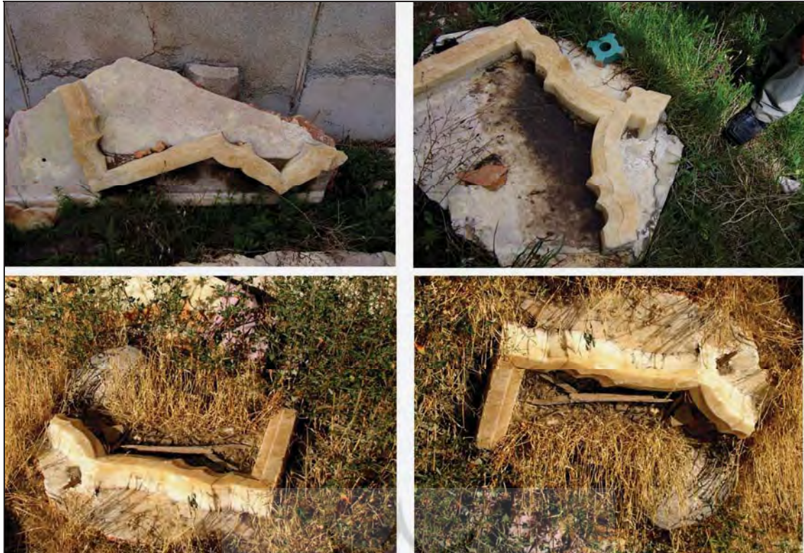
ت. ۵. حوض شماره ۳ خانه صدقیانی قبل از تحویل به گروه مرمت به صورت کاملا شکسته شده (ماخذ: دفتر فنی دانشگاه هنر اسلامی تبریز)
