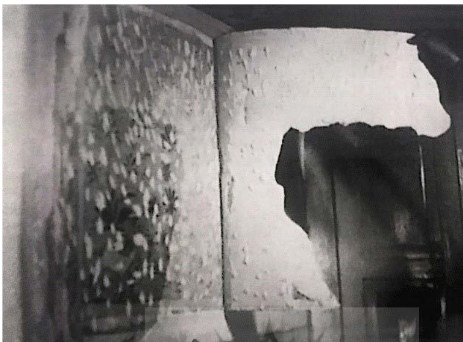
شکل ۲: جداسازی لایه نقاشی الحاقی (لایه نقاشی برین) از روی نقاشی اصلی (لایه زیرین)، کاخ چهل ستون (زاندر، ۱۳۹۶). Fig. 2: Separation of the upper painting layer (overlay layer) from the main painting (lower layer), Chehel Sotoun Palace (Zander, 1396).
