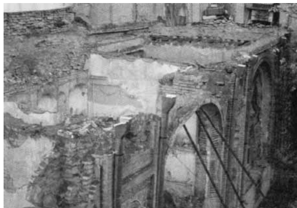
شکل ۴- وضعیت نمای جنوبی تکیه بیگلربیگی کرمانشاه قبل از مرمت
