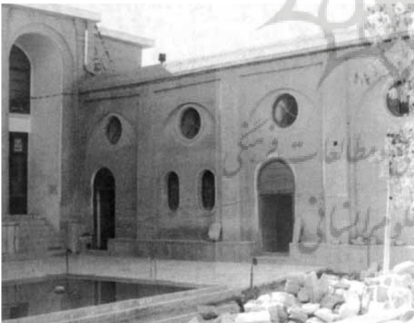
شکل ۱۵- نمای نورگیرهای قسمت ساختمان موزه سنندج پس از مرمت
