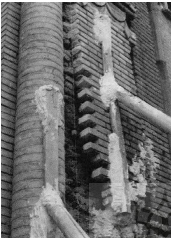
شکل ۸- نمای دیوار قسمت غربی شهرداری قدیمی کرمانشاه قبل از مرمت
