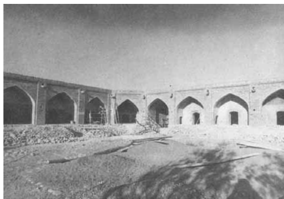
شکل ۷- نمای داخل کاروانسرای بیستون پس از مرمت
