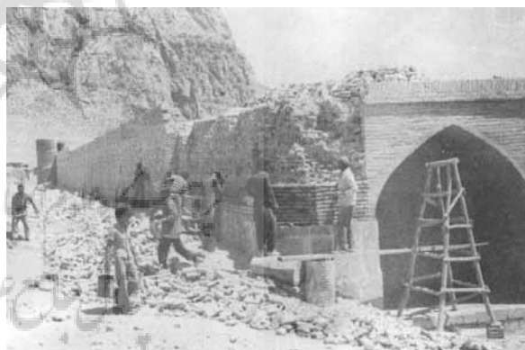
شکل ۶- نمای قسمت غربی کاروانسرای بیستون قبل از مرمت
