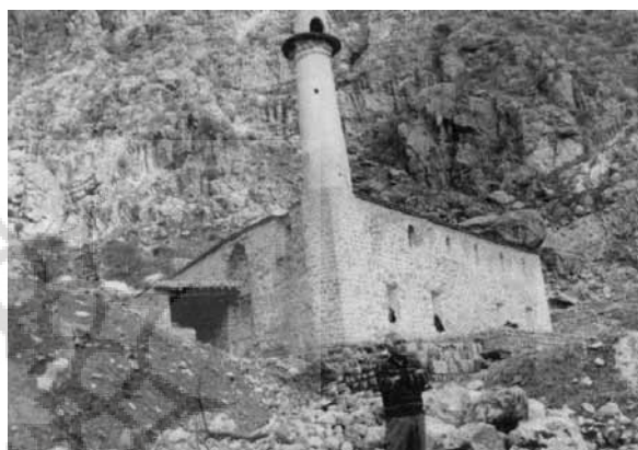
شکل ۱۱ - نمای غربی مسجد عبدالله بن عمر ریجاب پس از مرمت
