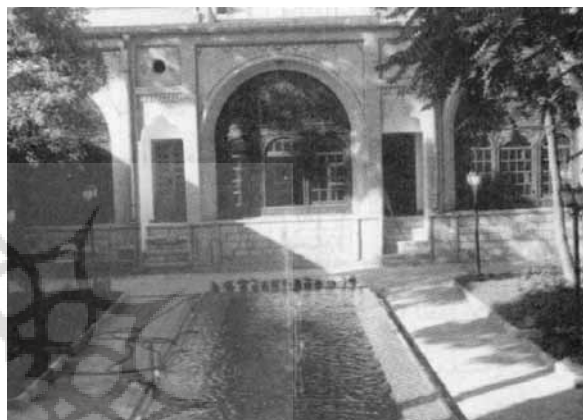
شکل ۵- وضعیت نمای جنوبی تکیه بیگلربیگی کرمانشاه پس از مرمت
