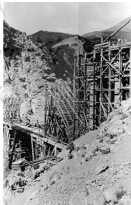
تصویر ۲۲ - نمایی دیگر از قالب دال قوسی
