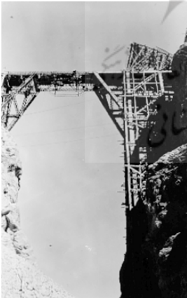
۱۸ - تصویر انتقال مصالح و قطعات پیش ساخته از تصویر ۲۰ - دو پایه دار بست بهم وصل می شوند.
