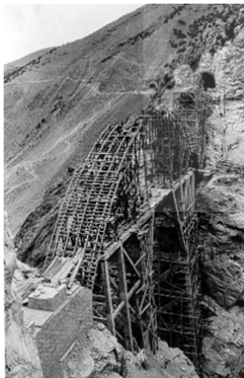
تصویر ۲۴ - نمایی از دو نیمه قالب قوسی و دهانه ورودی و خروجی تونل
