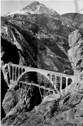
۳۳ - تصویر اجرای نمای آجری پل تصویر ۳۵ - ریل گذاری موقت جهت تسهیل در انجام امور بر روی پل
