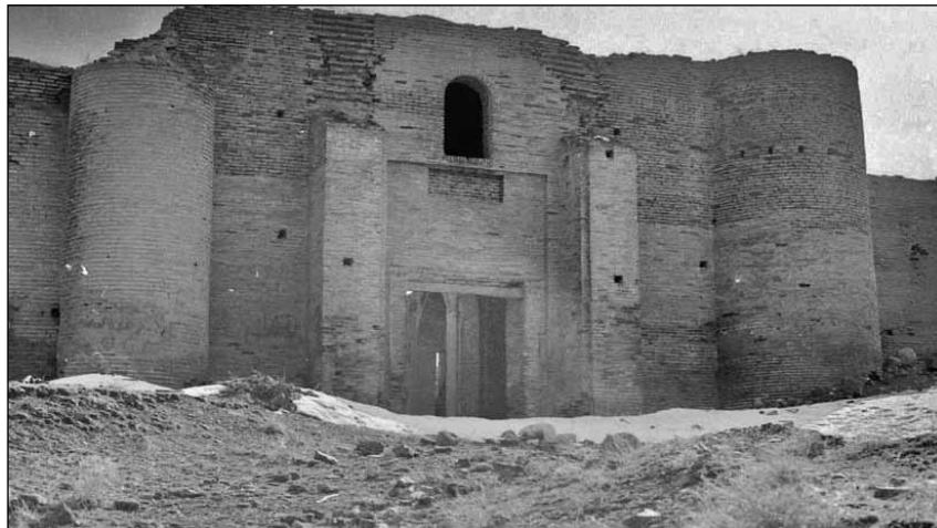
نمای ایوان ورودی حیاط مجموعه
