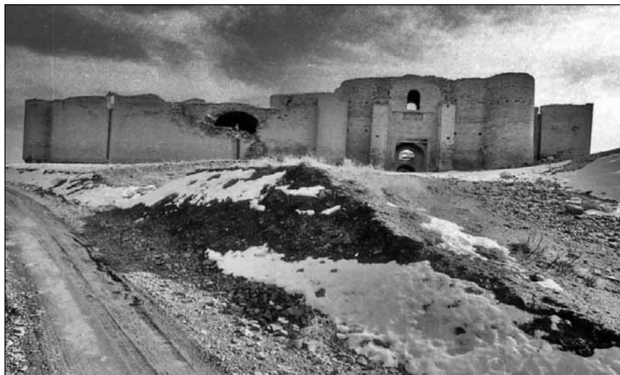
نمای جبهه ورودی مجموعه رباط علاقبند
