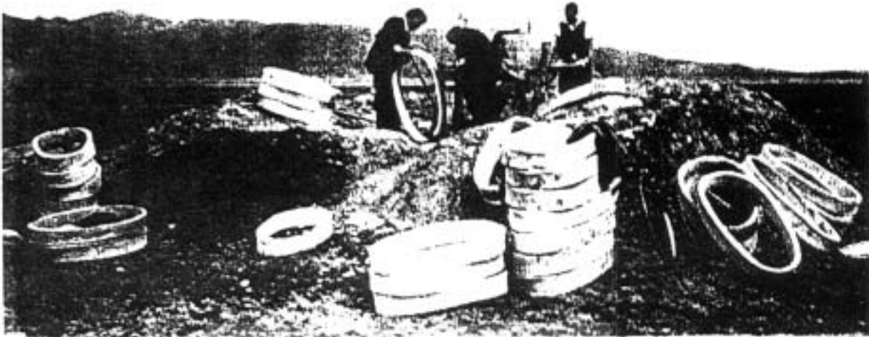
شکل ۳- کول‌های سفالین جهت کوره قنات در زمین‌های شولاتی از کتاب آب و فن آبیاری در ایران باستان
