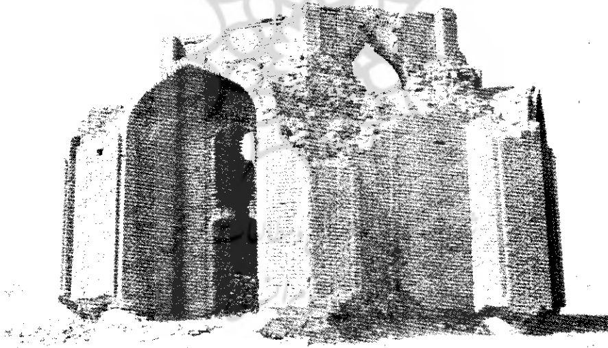
مقبره جغتین گیسور گناباد از سمت جنوب شرقی
