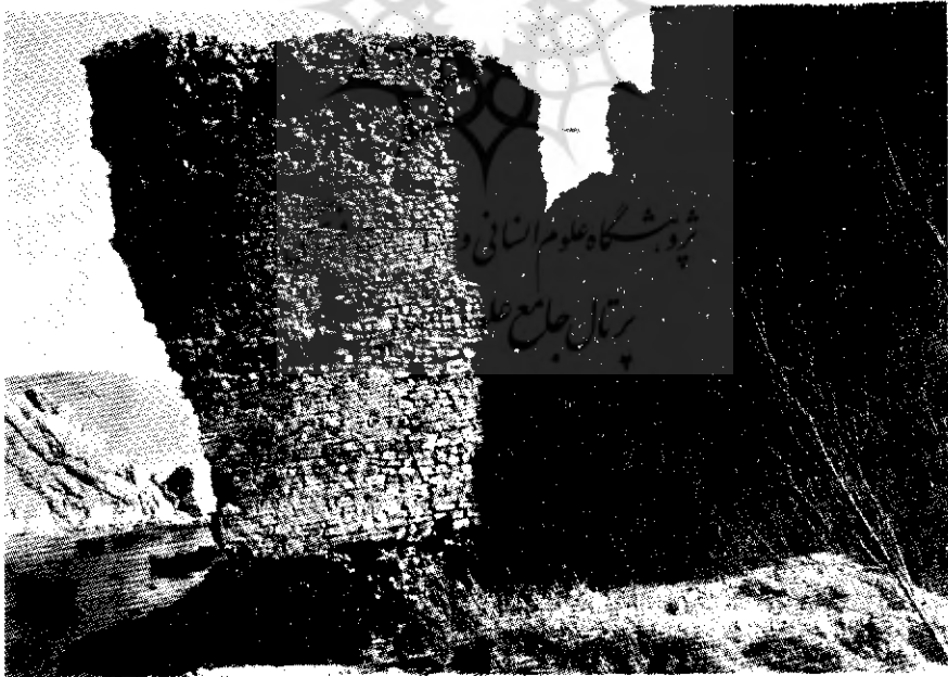
تصویر ۱۰- در این تصویر دیواره باقیمانده سمت راست سد سربند ایزدخواست دیده میشود در این تصویر شیوه بنائی و نحوه ساختمان دیواره سد بهتر دیده میشود. (عکس از نگارنده)
