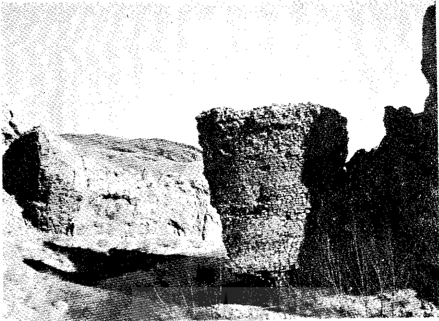
تصویر ۹- تصویری از رودخانه ایزدخواست و سد سربند که قسمت میانی آن فروریخته و از بین رفته و تنها دو بخشی که بیرون از رودخانه بوده و فشار کمتری بآن وارد میشده برپا مانده است.
