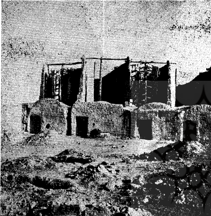
عکسی از وضعیت پُره‌ها و نمائی از قسمت بیرونی آسیا عکسی از وضعیت آسیاهای بادی در بخش خواف
