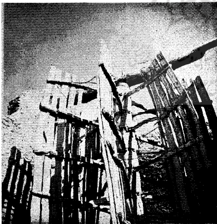
عکسی از پره ها و وضع قرار گرفتن ، پره ها ، پشینیان ، بازوها و خرپل و سره پل
