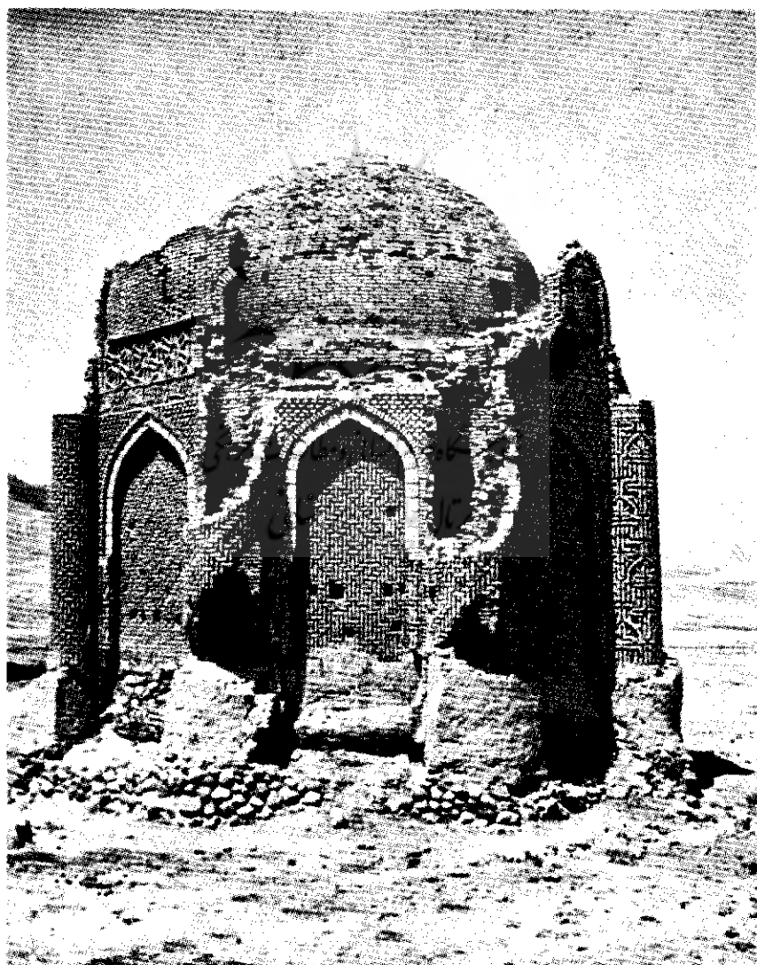
تصویر ۸ - الف منظره‌ای از برج اول که بقایای دو ستون توخالی مخصوص راه
