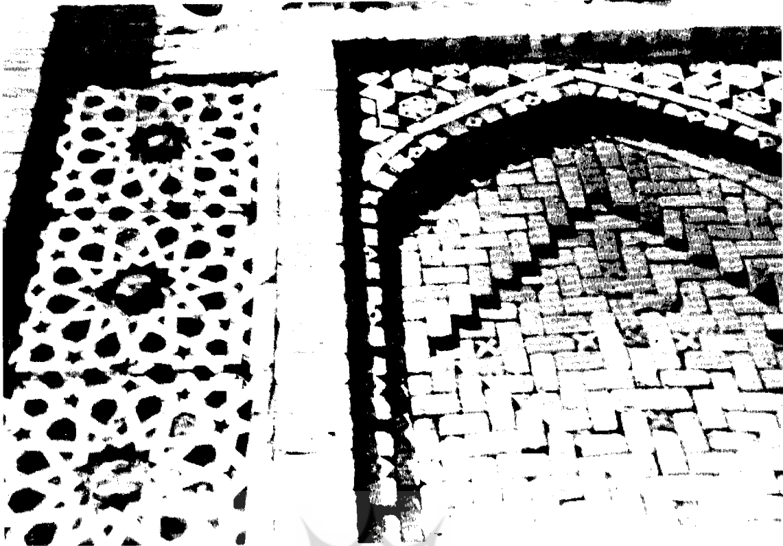
ترتیب آجری و سفالی نمای دیوار غربی ایوان شمالی مسجد جامع گناباد
