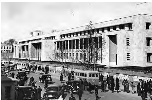
تکیه دولت برای ساخت این ساختمان (بانک ملی، شعبه بازار) تخریب شد.
