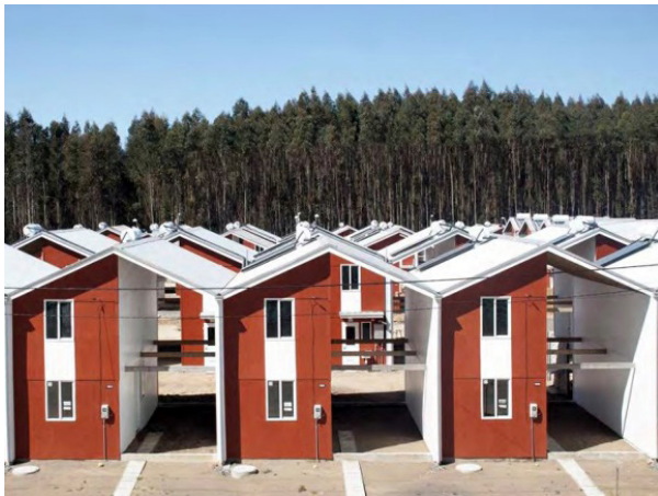
تصویر ۱. نمای کلی از پروژه خانه‌های نیمه ساخت ایکیکه شیلی (ماخذ تصویر: پورا کبر و خانلو، ۱۳۹۵)
