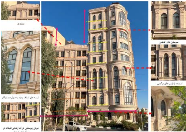
تصویر ۳. در خط آسمان این منطقه کاملاً اضافه طبقه و عدم رعایت قانون مشهود می‌باشد. در طراحی نما نیز استفاده از قوس‌های مراکشی و سنتوری ایجاد خطوط عمودی و نژینات سنگین مصداق‌های اشرافی‌گری و فخر فروشی است عدم رعایت ترازها و امتداد خطوط نما در نیش نسترن موجب شده ۳ ملک با وجود نمای فاخر منجر به بروز آشفتگی بصری شوند. ماخذ نگارنده
