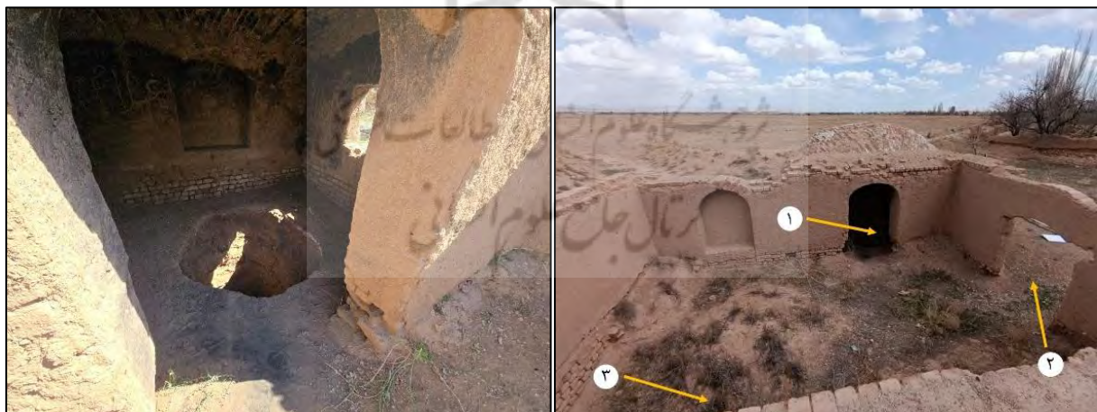
شکل ۹: فضای داخلی بخش غربی آسیاب: (۱) درب ارتباطی اتاق اصلی و انبار (۲) ورودی اصلی (۳) محل قرارگیری سنگ آسیاب (تاریخ عکس، سال ۱۴۰۳) شکل ۱۰: فضای داخلی بخش شرقی و چاهی که در وسط آن حفر شده است (تاریخ عکس، سال ۱۴۰۳)
