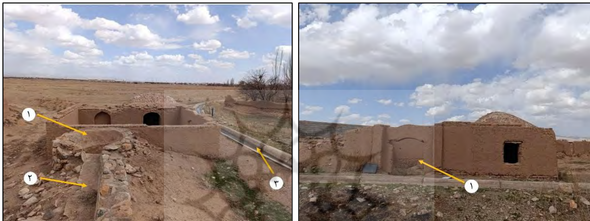
شکل ۷: جبهه جنوبی آسیاب: (۱) ورودی اصلی (تاریخ عکس، سال ۱۴۰۳) شکل ۸: مسیر ورود آب به آسیاب: (۱) تنوره (۲) جوی منتهی به تنوره (۳) جوی آب جدید (تاریخ عکس، سال ۱۴۰۳)
