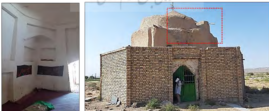
شکل ۱۱. آرامگاه راه‌چمن؛ راست: دید از شمال شرق کادر قرمز پلکان حذف شده؛ چپ: فضای داخلی گنبدخانه و پرشدگی کف بنا
