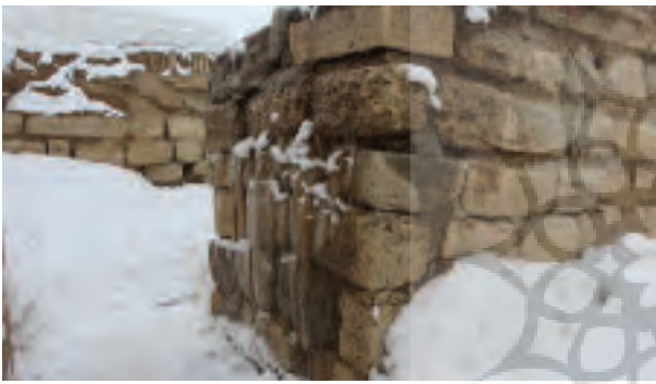
شکل ۱۳. از بالا به پایین تصاویری از یخبندان و هوازگی سنگ‌ها ناشی از نزولات جوی بر روی دیوارها (عوارض این مشکلات شامل تورم و پوسته‌شدن سنگ‌ها) (عکس‌ها از نگارنده)
