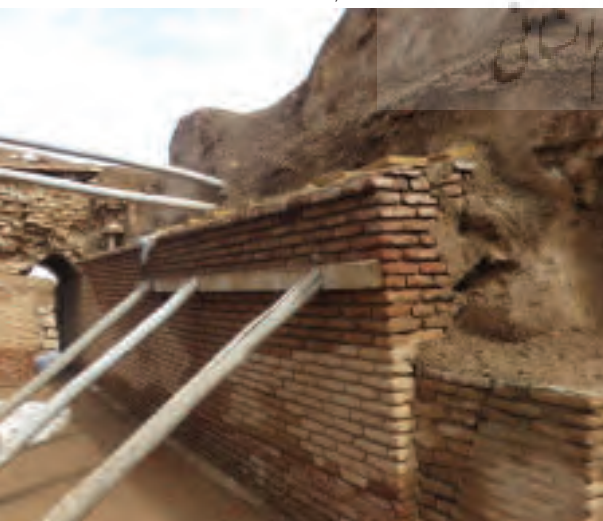
شکل ۱۴. تصاویری از رطوبت صعودی و نزولی ناشی از نزولات جوی بر روی دیوارها و کف بناها باعث سست شدن مصالح و ملاحها و همچنین شرایط را برای رشد گیاهان و حضور جانوران فراهم می‌نماید. (عکس‌ها از نگارنده)
