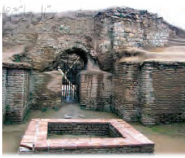
شکل ۱۴. تصاویری از رطوبت صعودی و نزولی ناشی از نزولات جوی بر روی دیوارها و کف بناها باعث سست شدن مصالح و ملاحها و همچنین شرایط را برای رشد گیاهان و حضور جانوران فراهم می‌نماید. (عکس‌ها از نگارنده)
