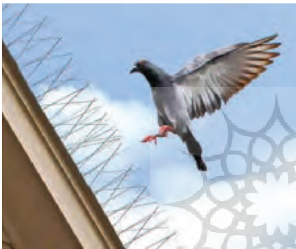
شکل ۲۰. خارک تکنیک مدرن محرومیت پرندگان از لانه گزینی و استقرار. منبع عکس: عباس اهوراناب
