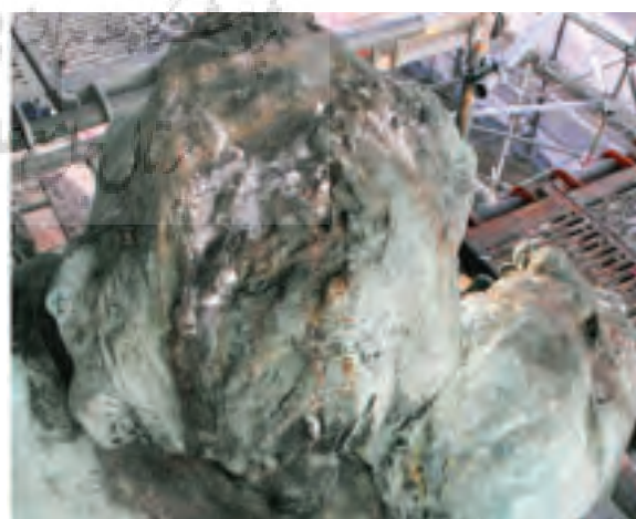
شکل ۱. تخریب منظر و ساختار مجسمه های شهری بر اثر فضولات پرندگان در شهر پراگ عکس از کاترین کریسلووا، ۲۰۱۷
