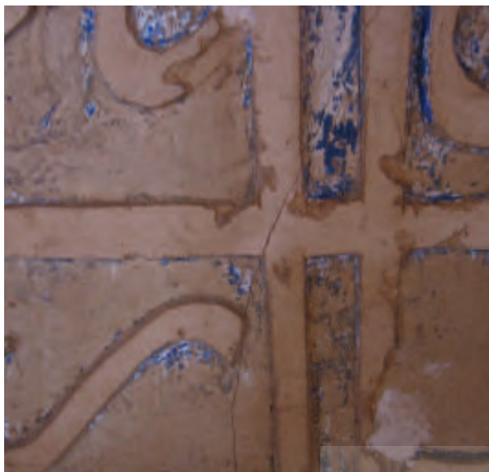
شکل ۲۷. ایجاد ترک در سطح کتیبه گچبری تزئینی (عکس از نگارنده)
