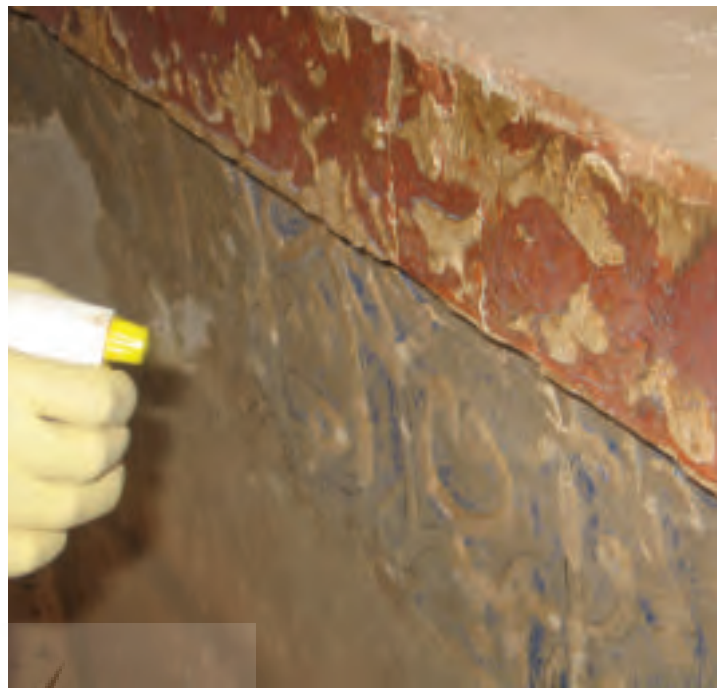
شکل ۳۵. تثبیت اولیه لایه های سست رنگ و گچبری با اسپری پریمال ۳ درصد (عکس از نگارنده)
