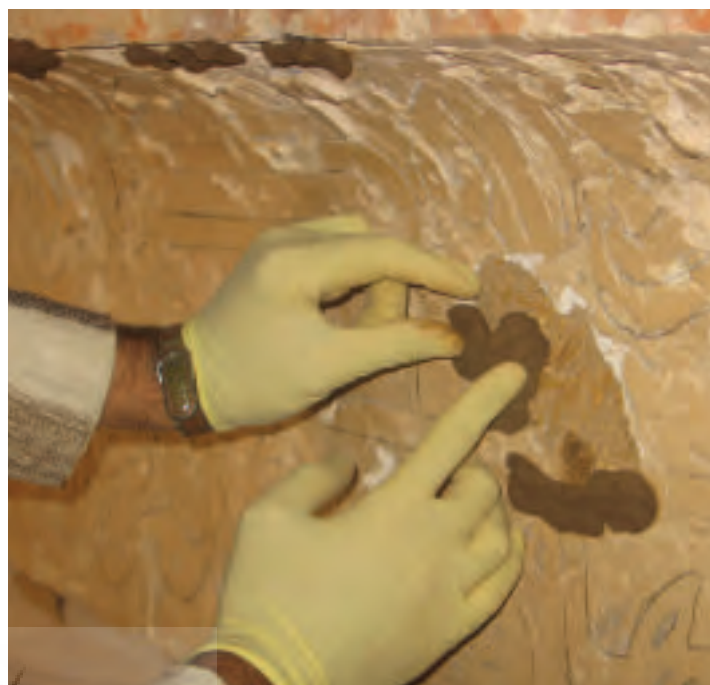
شکل ۳۹. ایجاد سونداژ و قرار دادن نوارهای گلی در اطراف برای تزریق محلول استحکام بخش (عکس از نگارنده)
