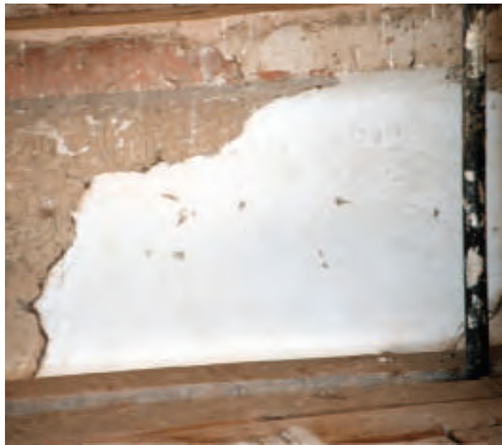
شکل ۳۴. مرمت غلط کتیبه گجبری با پر کردن کمبودها به شکل ناشیانه با گچ که موجب زشت و بدنما شدن سطح کار شده (عکس از نگارنده)
