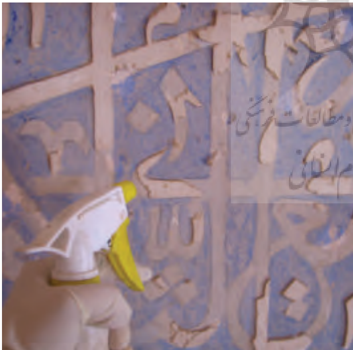
شکل ۴۴. تثبیت نهایی بخش های بازسازی شده با محلول پارالوئید (عکس از نگارنده)
