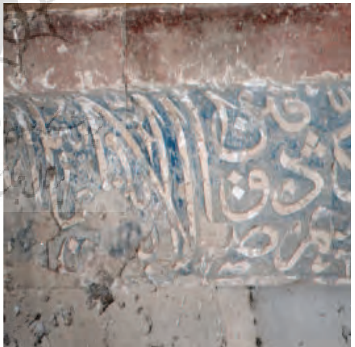
شکل ۳۰. راست: دور نمایی از ریزش کل کتیبه گچبری به همراه بستر زیرین کار از سطح بدنه بنا؛ چپ: نمایی نزدیک از ریزش کل کتیبه گچبری به همراه بستر (عکس از نگارنده)
