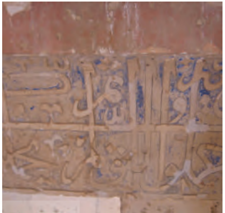
شکل ۲۹. ریزش رنگ آبی بستر کتیبه گچبری چپ و راست (عکس از نگارنده)
