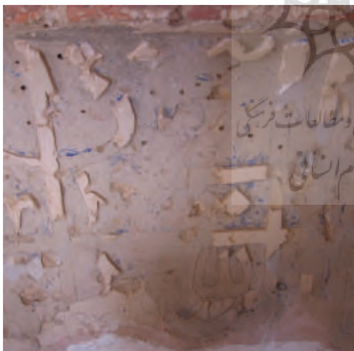
شکل ۳۳. راست: سوراخ های بزرگ ایجاد شده در سطح کتیبه گچبری در اثر فعالیت موربانه؛ چپ: سوراخ های کوچک ایجاد شده در سطح کتیبه گچبری توسط موربانه (عکس از نگارنده)
