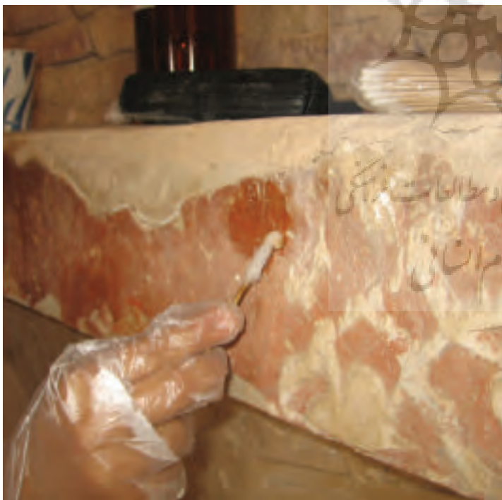
شکل ۳۸. پاکسازی گچبری به روش شیمیایی با الکل اتانول (عکس از نگارنده)
