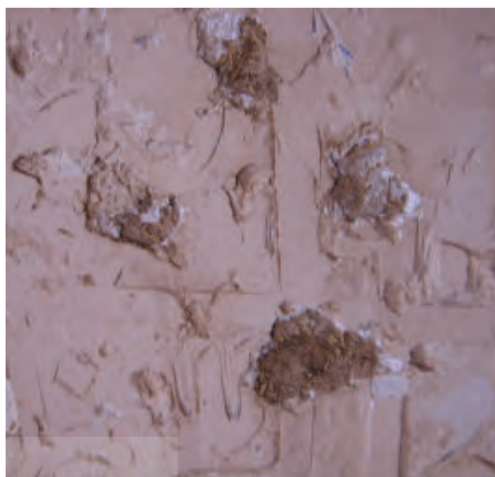
شکل ۳۱. تخریب کتیبه گچبری در اثر اصابت سنگ توسط عوامل انسانی (عکس از نگارنده)
