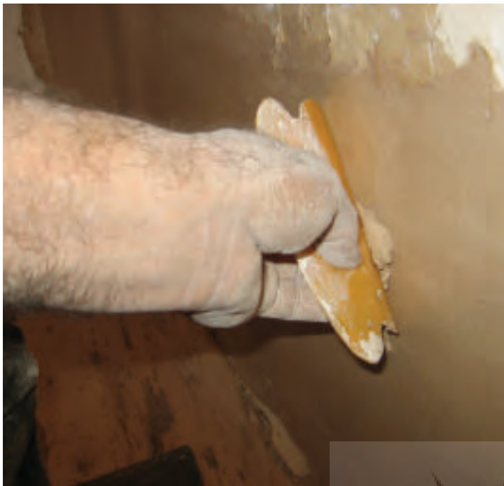
شکل ۴۲. پر کردن و بازسازی بخش های کمبود بزرگ کتیبه گچبری با ملات گچ اشکال چپ و راست (عکس از نگارنده)
