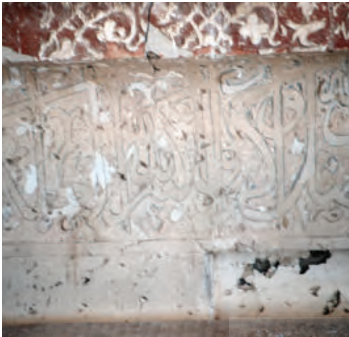
شکل ۲۹. ریزش رنگ آبی بستر کتیبه گچبری چپ و راست (عکس از نگارنده)
