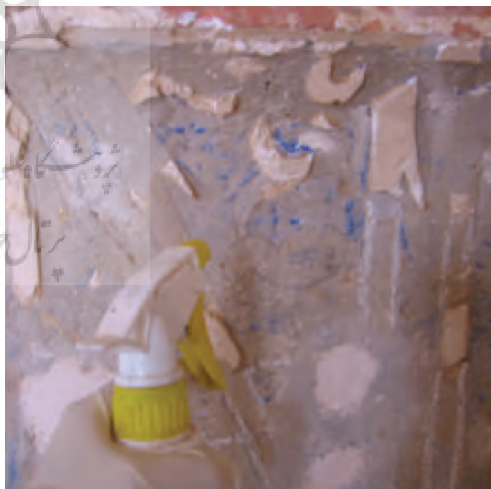
شکل ۴۱. استحکام بخشی تمام سطح کتیبه گچبری با محلول پارالوئید ۲۷B سه درصد در استون به روش اسپری کردن (عکس از نگارنده)
