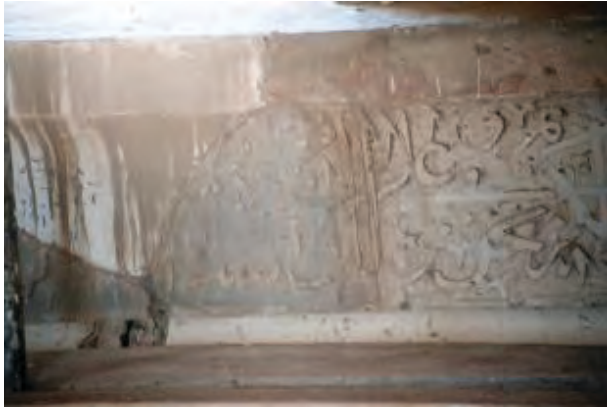
شکل ۲۴. آلودگی سطح کتیبه در اثر ریزش نزولات جوی از طریق سقف (عکس از نگارنده)
