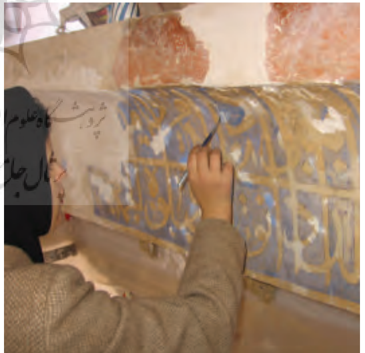
شکل ۴۳. موزون سازی رنگی بخش های بازسازی شده کتیبه گچبری (عکس از نگارنده)
