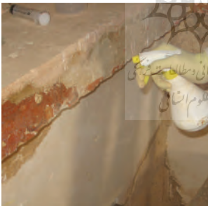
شکل ۴۱. استحکام بخشی تمام سطح کتیبه گچبری با محلول پارالوئید ۲۷B سه درصد در استون به روش اسپری کردن (عکس از نگارنده)
