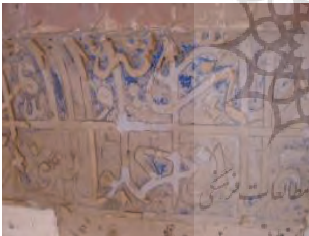
شکل ۲۵. تیره و چرک شدن سطح کتیبه در اثر آلودگی‌های محیطی (عکس از نگارنده)
