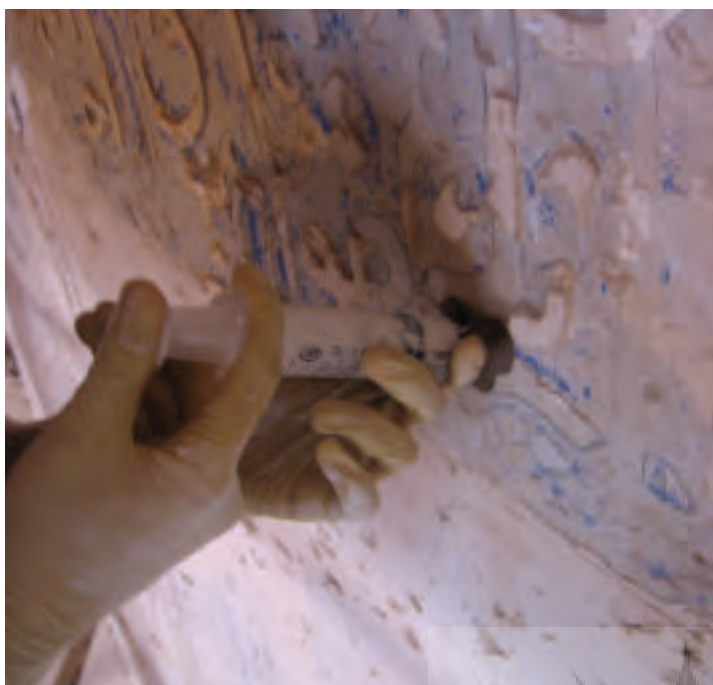
شکل ۴۰. تزریق محلول استحکام بخش پلکستول و گچ به پشت کتیبه (عکس از نگارنده)
