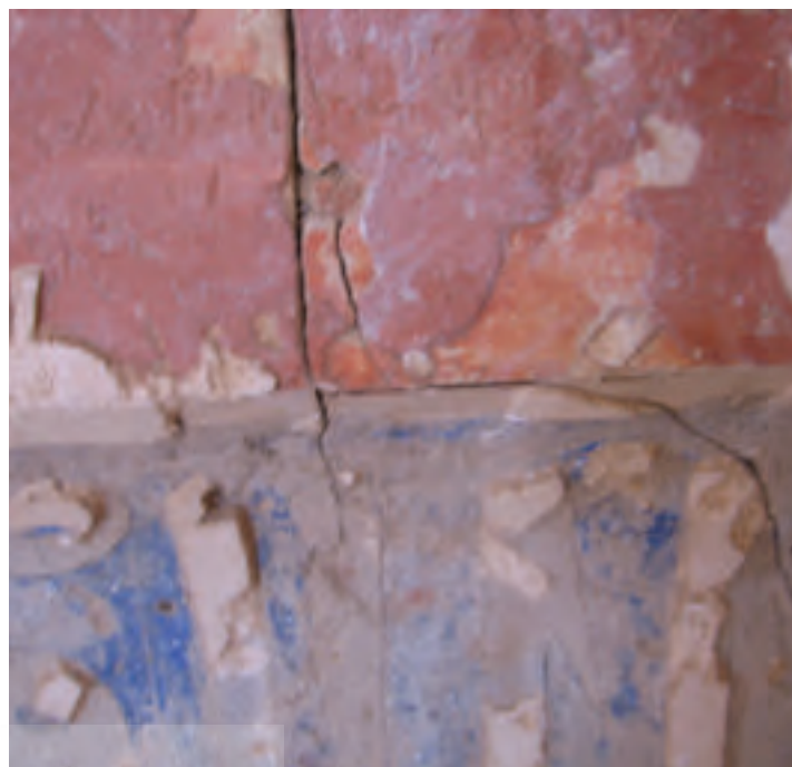
شکل ۲۶. ایجاد شکاف در سطح کتیبه گچبری تزئینی (عکس از نگارنده)
