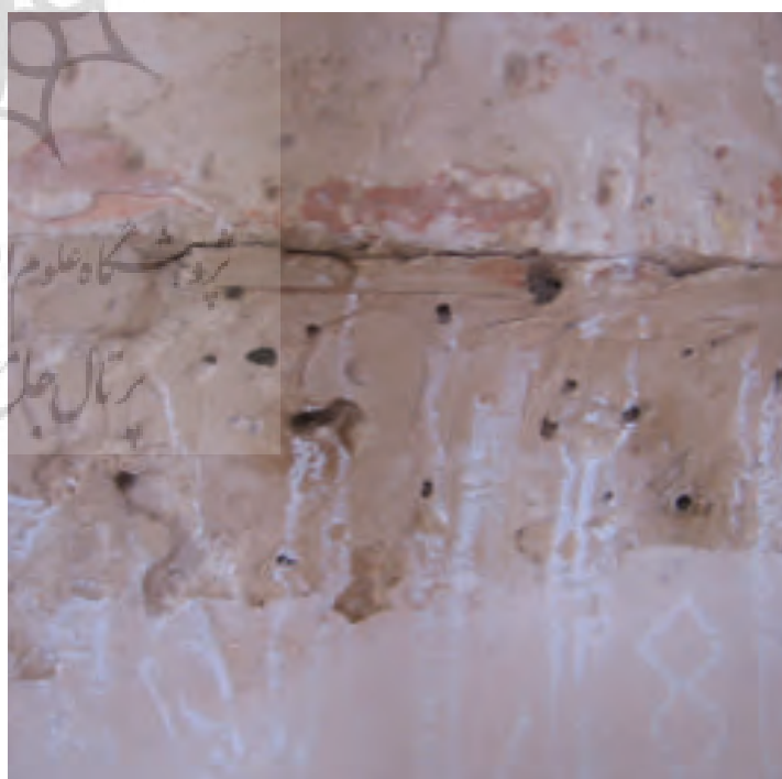
شکل ۳۳. راست: سوراخ های بزرگ ایجاد شده در سطح کتیبه گچبری در اثر فعالیت موربانه؛ چپ: سوراخ های کوچک ایجاد شده در سطح کتیبه گچبری توسط موربانه (عکس از نگارنده)
