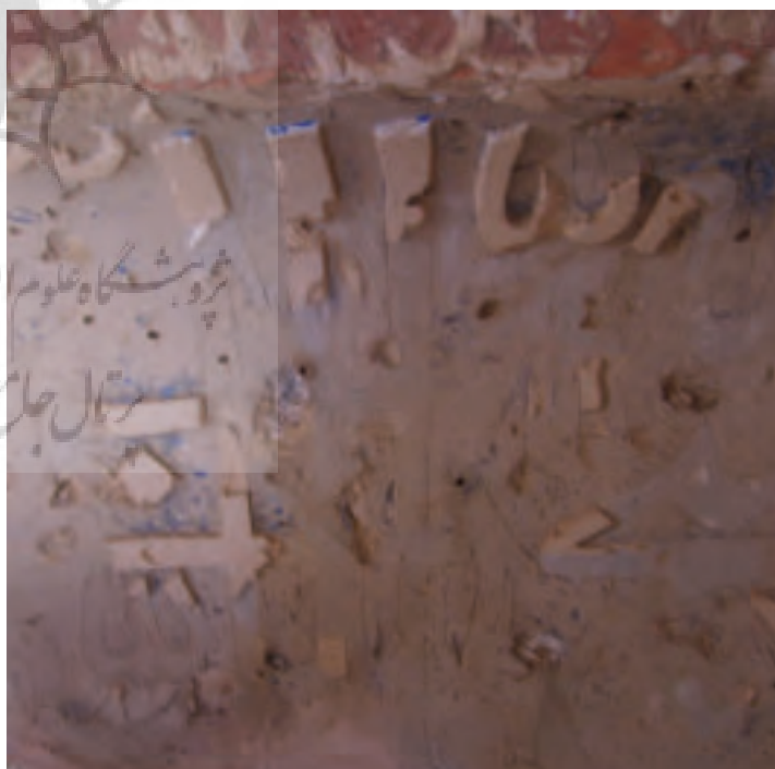
شکل ۲۸. راست: تخریب و ریزش کتیبه گچبری از بستر آن؛ چپ: نمای نزدیک نحوه تخریب و ریزش کتیبه گچبری از بستر آن (عکس از نگارنده)
