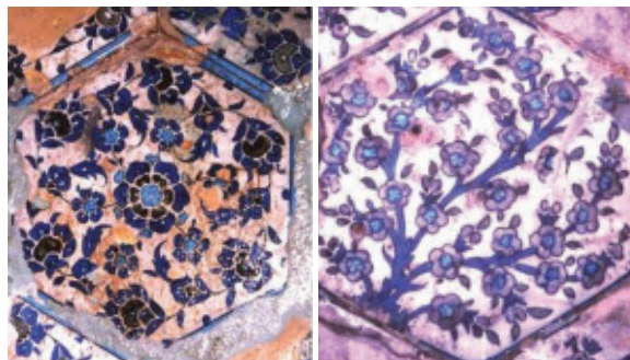
شکل ۲۶. بنای حمام بورسه، کاشی‌های آبی - سفید (Gök, 2004: 151)
