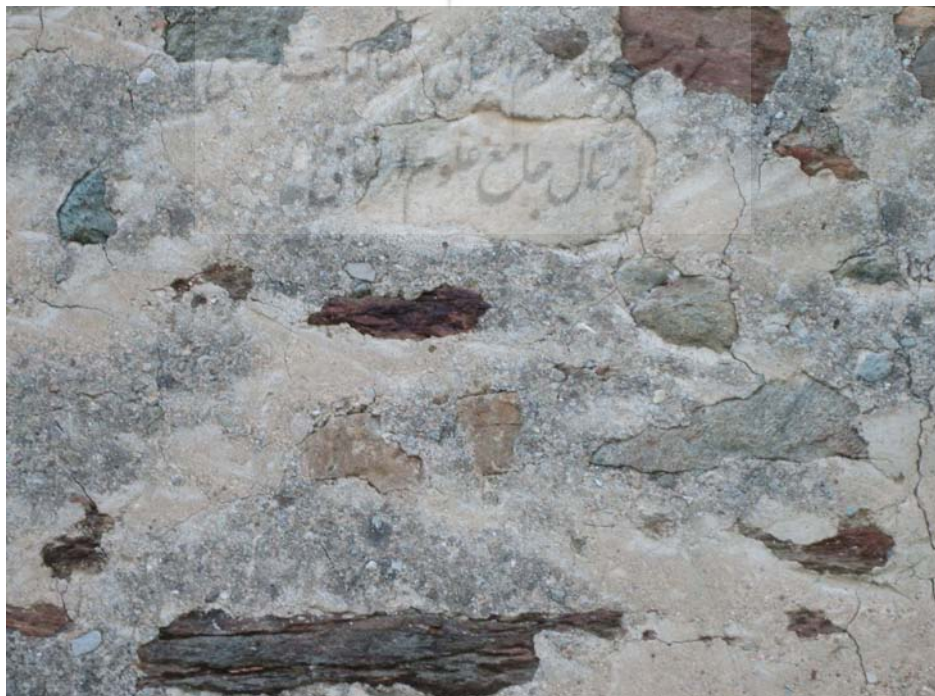
تصویر ۷. تصویری از فن رومی اندودکاری پیترااسا. مأخذ: Flüge, 2012; Weyer et al. 2015.
