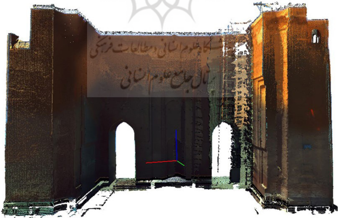
تصویر ۲. دو نمونه برداشت از جبهه‌های جنوبی و شمالی سازه ارگ علی‌شاه با دستگاه لیزر اسکنر ۳ بعدی. مأخذ: نگارندگان.
