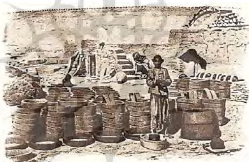
INDIGÈNE FABRICANT D'ANNEAUX EN TERRE CUIE POUR LA CONSTRUCTION DES KANATS
