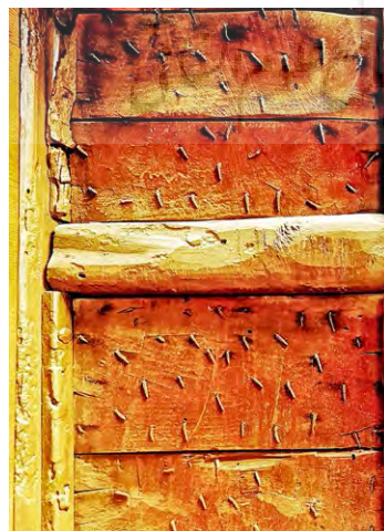
تصویر ۲۷: چگونگی پرچ گل‌میخ از تخته منبت‌کاری بر تخته زیرین در منبر حسینیه چارسوق آران
