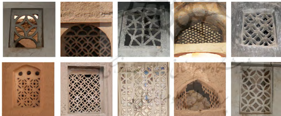
تصویر ۳۳: پنجره‌های مشبک خانه‌ها در قلعه جندق، ۱۳۸۹
