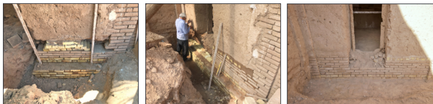
شکل ۵. احداث پی خشتی / آجری در قسمت بیرونی دیوار غربی فضای ۱۵.
