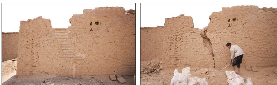
شکل ۸. دوخت و دوز ترک دیوار شمالی فضای ۲۳ پس از رفع علل آسیب.
