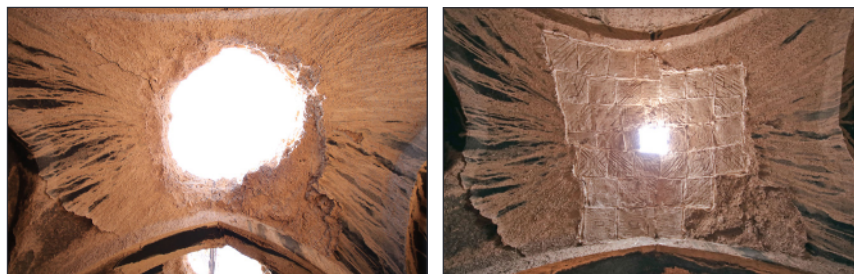
شکل ۱۴. بازچینی خشت‌های تخریب شده از طاق فضای ۳۰ با خشت‌هایی به ابعاد ۲۲/۵×۲۲/۵×۵/۴ سانتی‌متر.
