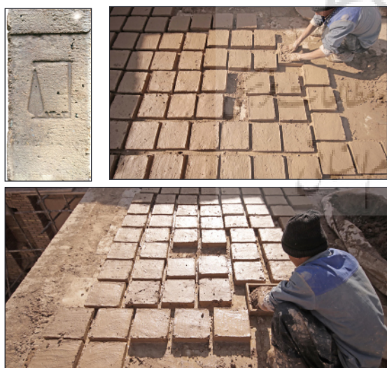
شکل ۴. فرایند تولید خشت کارگاهی با نقش مهری و ذکر تاریخ، برای مشخص شدن خشت مرمتی از خشت اصلی بنا.
