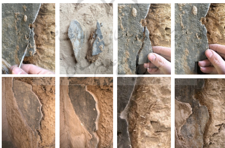
شکل ۳۰. تثبیت ازاره‌ی گچی ایوان با تزریق دوغاب گچ، اجرای ماهیچه‌ی گچی و اتصال مجدد قطعات با استفاده از محلول پلکستول ۳۰ درصد در آب.
