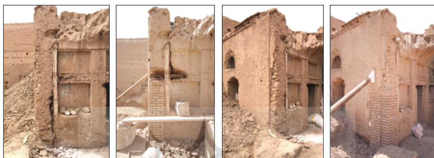
شکل ۶. بازچینی قسمت‌های فرسوده از ستون بیرونی فضای ۱۵ و ایجاد اتصال چوبی در قسمت داخلی ترک.
