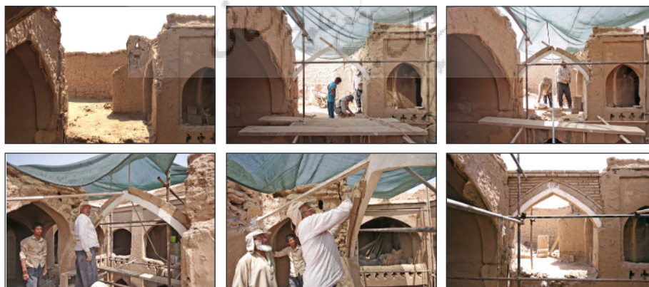
شکل ۲۴. عملیات بازسازی طاق‌نمای تخریب شده در قسمت جنوب غربی حیاط.
