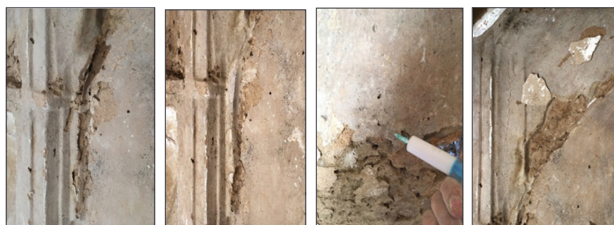
شکل ۲۹. تثبیت اندوذهای دیوار شرقی ایوان شرقی (فضای ۰۹).
