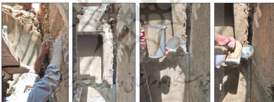
شکل ۷. تزریق دوغاب گچ در ترک تقاطع دیوار شمالی و شرقی فضای ۱۵.
