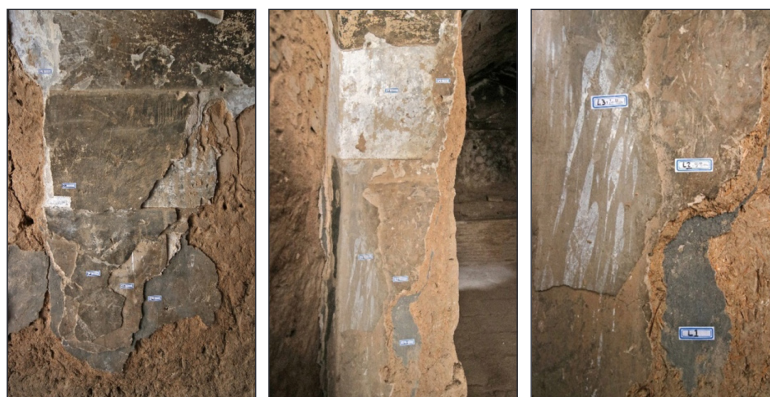
شکل ۲۷. تعدد لایه‌های ازاره‌ی گچی در دیوار غربی فضای شماره ۱۵.
