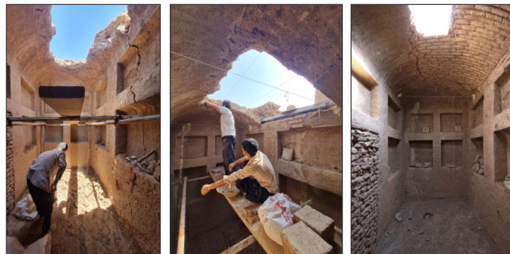
شکل ۱۱. بازسازی قسمت‌های تخریب شده از طاق فضای ۲۳.
