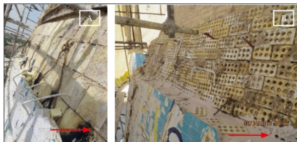
شکل ۶. قسمت دوغاب‌ریزی (فاصله بین کاشی‌ها و زیره گنبد) مسجد جامع عباسی؛ A- قبل از دوغاب‌ریزی ۱۳۹۴. ش؛ B- پس از دوغاب‌ریزی ۱۳۹۷. ش. (افشار، ۱۴۰۲).
