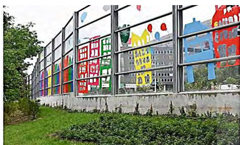
دیواره‌های حائل و صوتی نوآورانه جاذب آلودگی و ایجادکننده جذابیت بصری، دارای شفافیت برای امنیت
