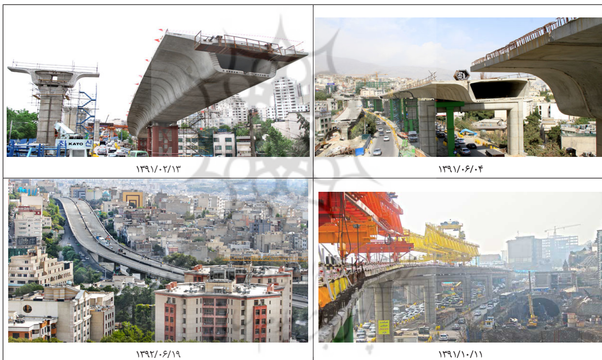
شکل ۳. تصاویر ساخت بزرگراه طبقاتی صدر
