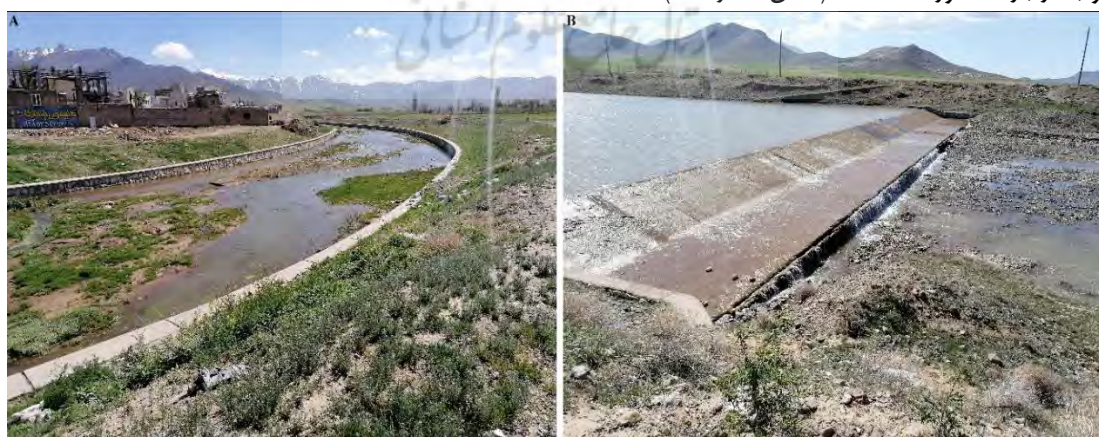
شکل ۱۲. کانال کشی در بستر آبراهه اصلی از عملکرد طبیعی و فرسایش کناره ها توسط آبراهه جلوگیری کرده و از ایجاد پیچ و خم (مئاندر)، جلوگیری کرده است.
