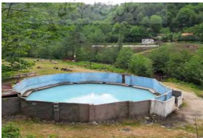
شکل ۲. آبگرم ازرود یا آب‌معدنی آرزو و یا ازرو، در روستای آری در بخش بندپی شرقی
