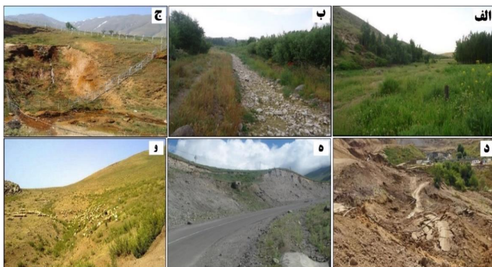
شکل ۸: الف، ب) نمای از تصرف بستر رودخانه خیوچای با توسعه اراضی کشاورزی و باغ‌ها؛ ج، د) به ترتیب: انتقال آب از روی دامنه برای آبرسانی به زمین‌های زراعی و پروژه انتقال آب به مناطق روستایی و فرسایش و لغزش دامنه به دنبال آن؛ ه) زیربری و از بین بردن پاشته دامنه به دنبال احداث جاده؛ و) چرای بی‌رویه دام‌های روستاییان در مراتع (منبع: نویسندگان، ۱۴۰۳)
