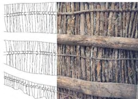
تصویر ۷: نمونه‌ای از سقف پوشیده شده با شش
