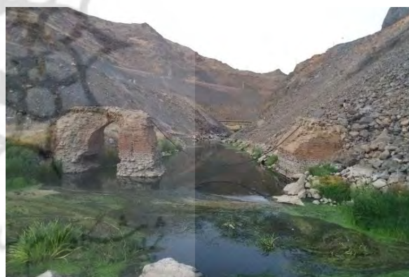
شکل ۹: پل باجی بگ (طالب‌نیا، ۱۳۹۷)
