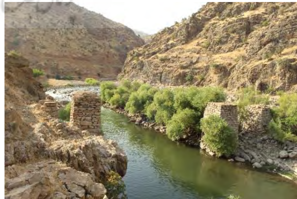
شکل ۱۹: پل ۲ دواب (طالب‌نیا، ۱۴۰۰)
