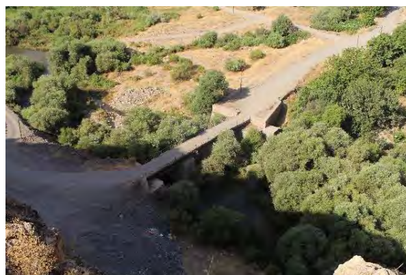
شکل ۲۱: پل درویش بگ (طالب‌نیا، ۱۴۰۰)
