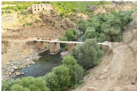
شکل ۱۸: پل ۱ دواب (طالب‌نیا، ۱۴۰۰)
