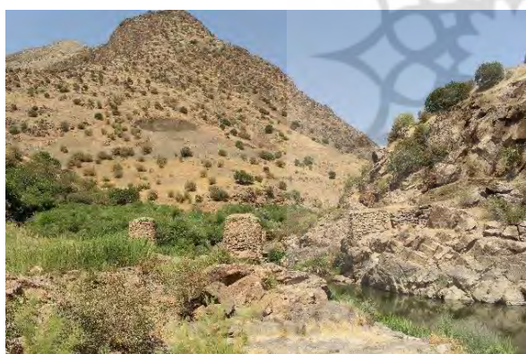
شکل ۱۰: پل کومله (صادقی‌راد، ۱۳۹۷)
