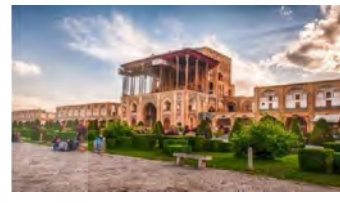
عدم وجود اختلاف ارتفاع در کف مسیرها
