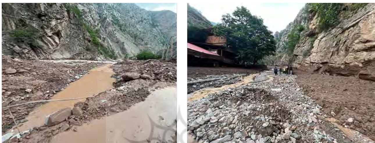
شکل (۴): تصاویری از عدم لایروبی رودخانه‌ها در چالوس
