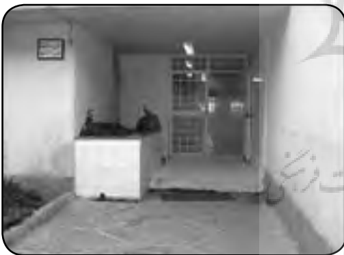
نمایی از ورودی‌های نامناسب و غیر کاربردی سرویس‌های بهداشتی جهت معلولان
