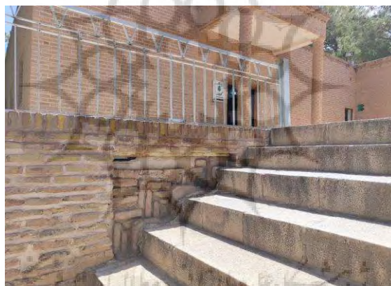
تصویر ۱۸. خشت خام راسته - خفته دوره قاجاریه به عنوان شاهد که با آجر کاری دوره پهلوی پوشیده شده است.
