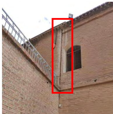
تصویر ۱۶. راست - برش ایجاد شده به عنوان شاهد از الحاق طبقه دوم به بنای دوره قاجار مربوط به دوره پهلوی اول
