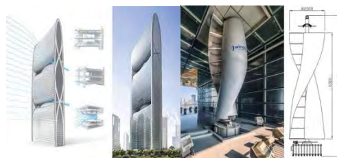
شکل ۱۲- توربین و نحوه عملکرد آن در برج رودخانه پرل (پیترست برج رودخانه پرل).
