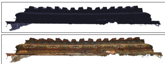
شکل ۷. خمش و شکم‌دادگی تیرهای سقف.
