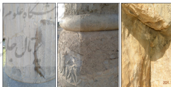
شکل ۶. وضعیت ملاط‌های ماسه‌سیمان در مرمت‌های مجموعه تخت‌جمشید از راست به چپ: صفحه جنوبی، آپادانا و کاخ صد ستون.
