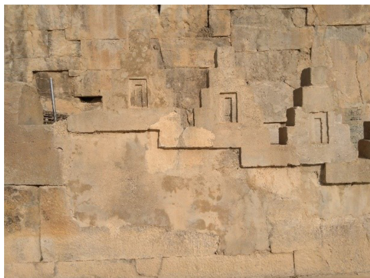
شکل ۵. کاربردهای مختلف ملاط سیمانی در پلکان ورودی در مرمت‌های گذشته تخت‌جمشید.
