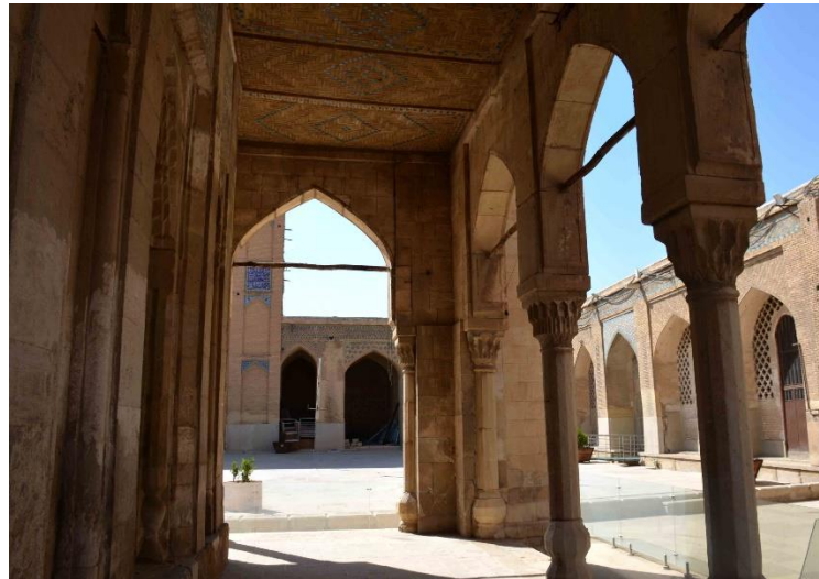
تصویر ۵: داخل رواق جنوبی خدای‌خانه، رو به شرق
