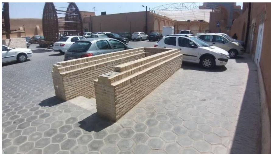
تصویر ۴. تصویری از دهانه ورودی پایاب قنات زارچ پس از آشکارسازی و مرمت بخش ورودی پایاب
