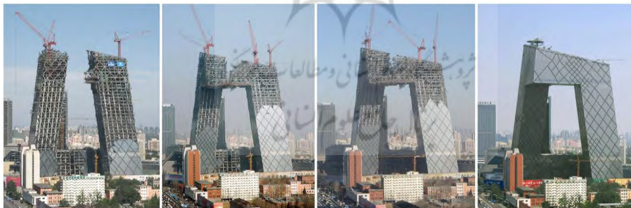
شکل ۱۲: روند ساخت ساختمان CCTV (ماخذ: Archdaily)
