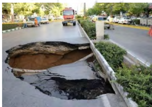
شکل (۵): فرونشست زمین در تاریخ ۱۴۰۲/۰۶/۱۸ در ساعت ۸ صبح در منطقه شهری مهرشهر خیابان چهارباندی
