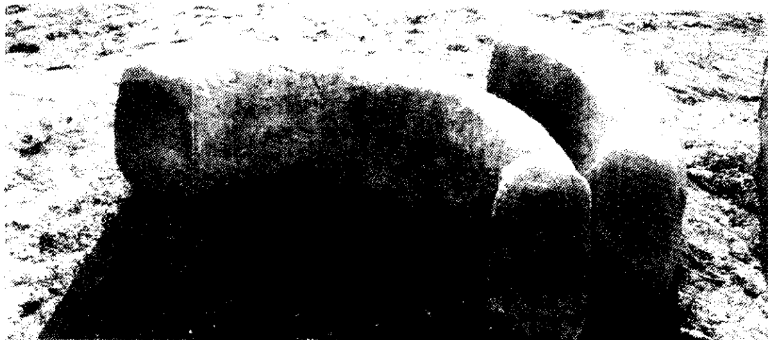
تصویر شماره ۲: بقایای تنبوشه‌های سنگی موجود در محوطه عمارت خورشید. عکس از نگارنده
