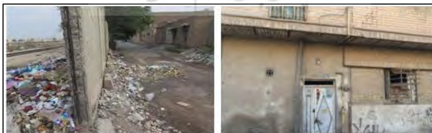
شکل ۵: وضعیت ابنیه و نخاله‌های ساختمانی و زباله‌های رهاشده در محله نهضت‌آباد (منبع: نویسندگان، ۱۳۹۸)
