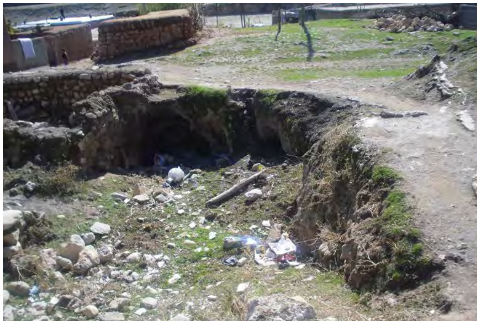
تصویر ۲۲ ب. دیوار و پی بناهای شهر شیروان در روستای کهلان Fig. 22b. Wall and Foundations of Shirvan in Kalan village
