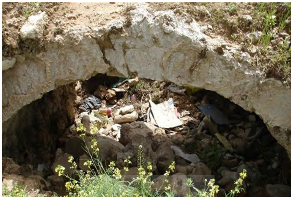
تصویر ۲۴. تاق قوسی ساخته شده از لاشه سنگ و گچ نیم کوب Fig. 24. An Arch Made of Rubble and Plaster Mortar
