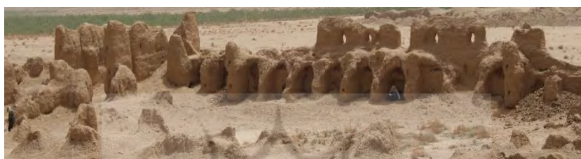
شکل ۴: ردیفی از ایوانچه در دیواره جنوبی مجموعه غربی قلعه علی‌آباد (نگارندگان: ۱۴۰۲)
