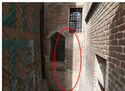
شکل ۹. مسدود شدن در ورودی ضلع جنوب غربی (همان) شکل ۱۰. تبدیل در مسدود شده به پنجره در ضلع جنوب غربی (همان)
