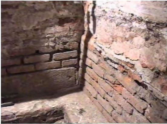
شکل ۶. اتصال دیوار شرقی مقبره به بدنه
