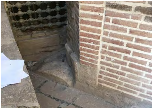
شکل ۷. محل اتصال دیوار الحاقی ضلع جنوب غربی (همان) شکل ۸. محل اتصال دیوار الحاقی ضلع جنوب غربی (همان)
